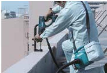
Perforación de concreto (con martillo combinado)
