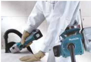
Corte de concreto (con esmeriladora)
